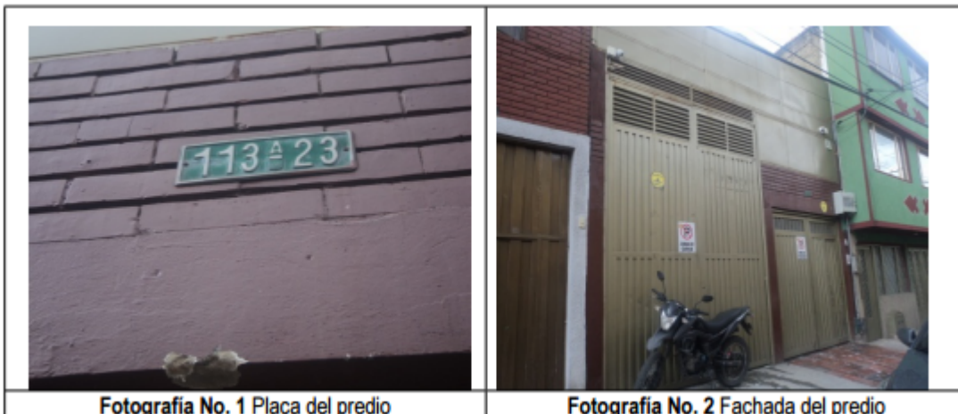
Fotografía No. 1 Placa del predio
